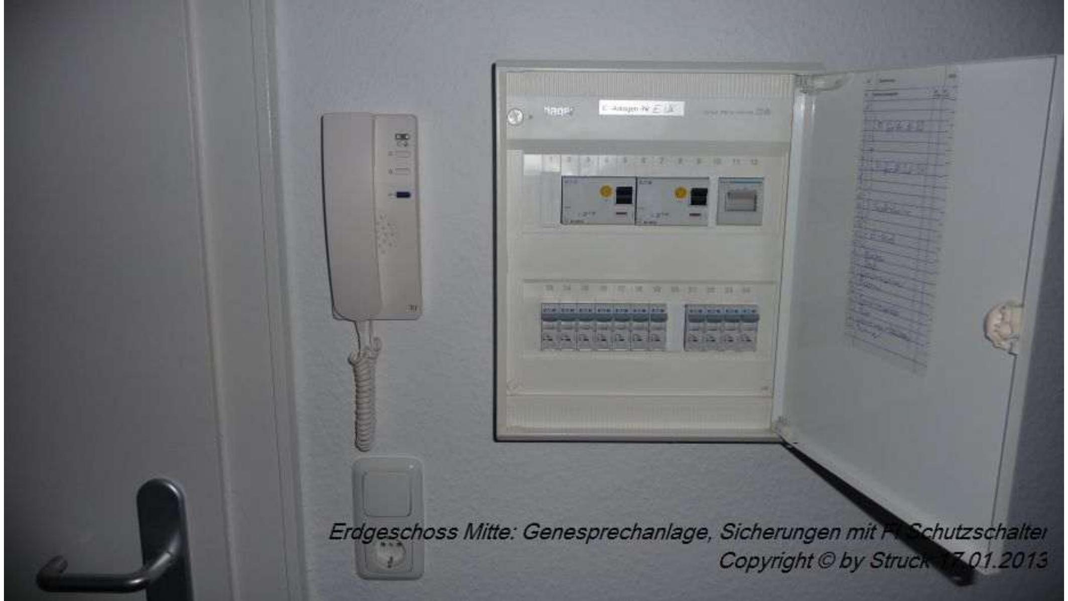
*Erdgeschoss Mitte: Genesprechanlage, Sicherungen mit FI-Schutzschalter
