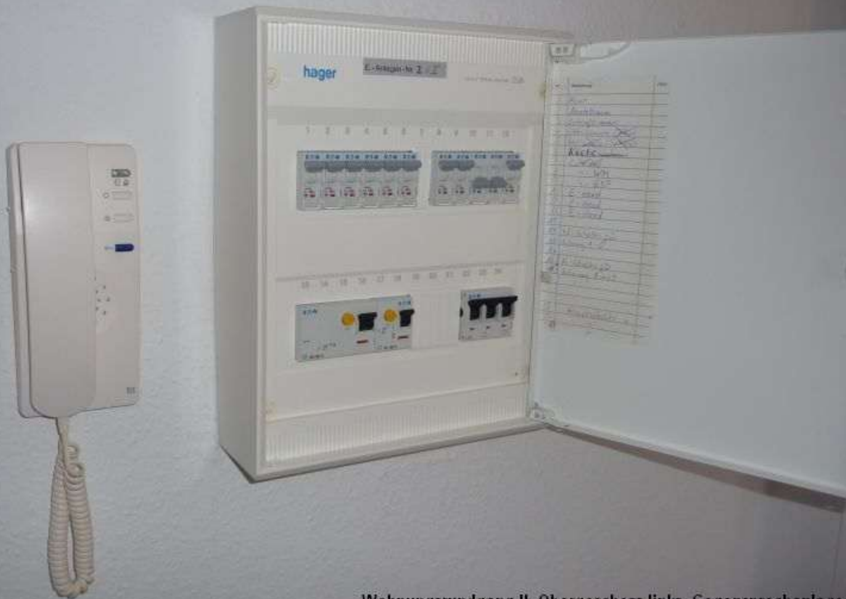
Wohnungsrundgang II. Obergeschoss links, Gegensprechanlage, Sicherungskasten Copyright © by Struck, 04.07.2015
